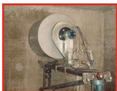
Forage de béton armé, pierre naturelle
