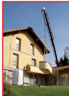
Sciage de béton armé, pierre naturelle
