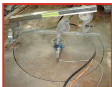
Sciage au câble
